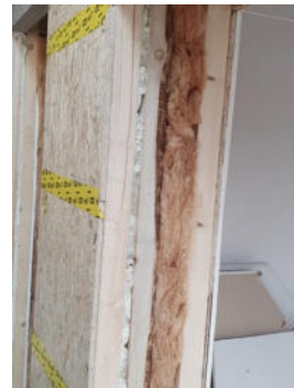
Querschnitt einer Innenwand
